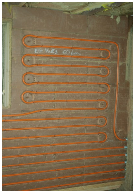
12. kép - vályogfal előregyártott falfűtő paneles hőleadó rendszerrel
