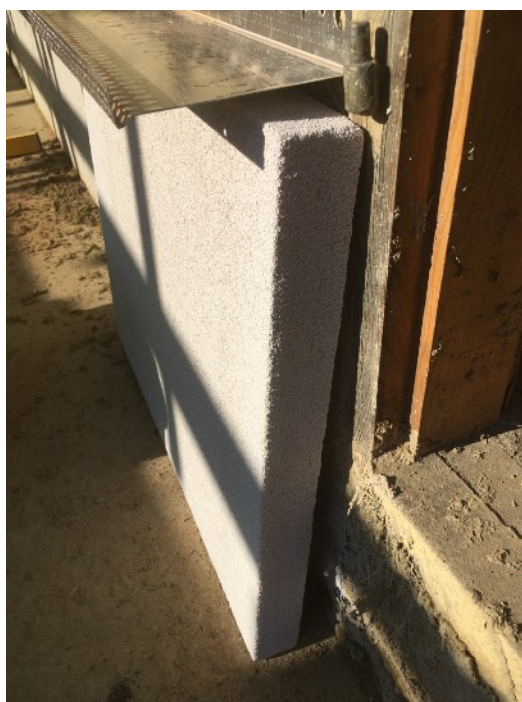
11. kép - lélegző utólagos lábazati hőszigetelés: kalciumszilikát táblákkal
